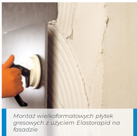
Rozprowadzenie zaprawy klejącej Elastorapid pacą zębatą na podkładzie cementowym
