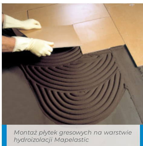
Montaż płytek gresowych z użyciem zaprawy klejącej Elastorapid na sklepcie wodoodpornej
