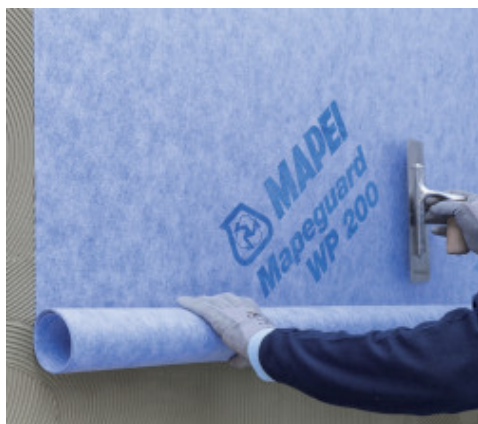
Układanie Mapeguard WP 200
