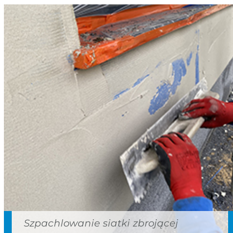
Montaż siatki zbrojącej w narożu budynku
