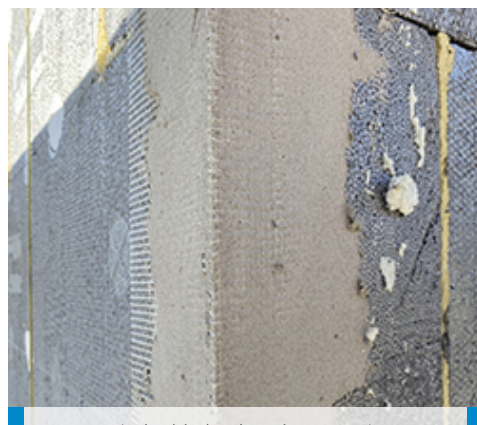
Montaż siatki zbrojącej w narożu budynku
