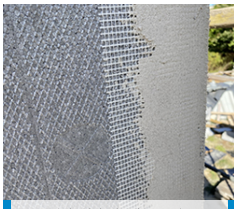
Montaż siatki zbrojącej w narożu budynku
