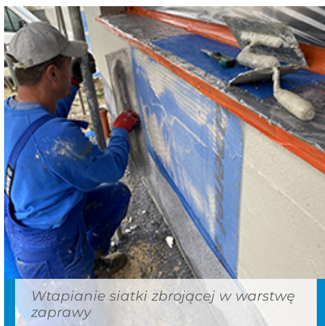
Montaż siatki zbrojącej w narożu budynku
